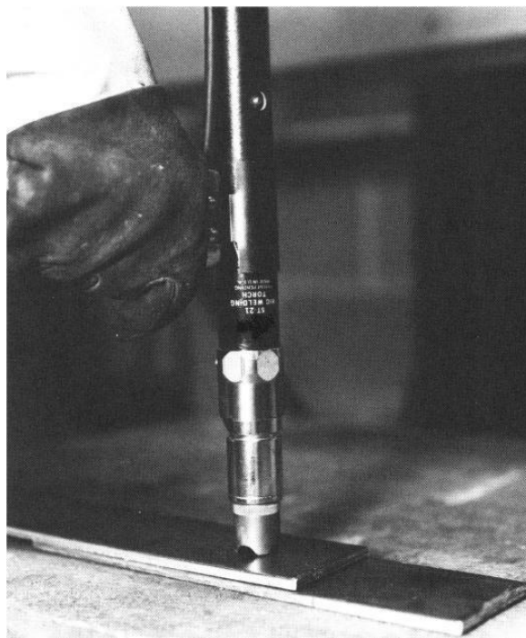
Figura 60 - Técnica de execução de uma solda pontual
